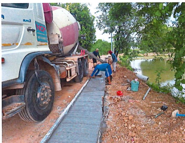
โครงการก่อสร้างรางระบายน้ำ คสล. หมู่ที่ ๒ (ซอยนาไก่อ ๑/๑)พร้อมวางท่อระบายน้ำ คสล.
