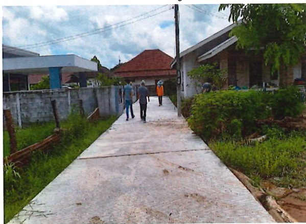
โครงการก่อสร้างถนน คสล. หมู่ที่ ๙ (ซอยหนองกอมเกาะ ๕/๓.๑)
