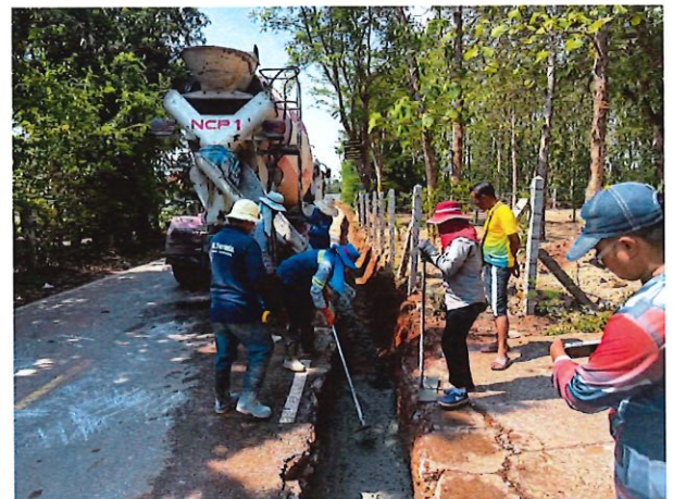
โครงการก่อสร้างรางระบายน้ำ คสล. หมู่ที่ ๒ (ซอยนาไก่อ ๑/๑)พร้อมวางท่อระบายน้ำ คสล.
