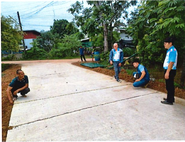
โครงการก่อสร้างถนน คสล. หมู่ที่ ๑๑ (บ้านน้อย ๖/๑)
