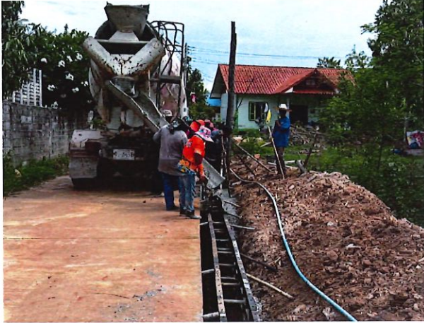
โครงการก่อสร้างรางระบายน้ำ คสล. หมู่ที่ ๔ (ถนนนาเหลาทอง-หนองกอมเกาะ)
