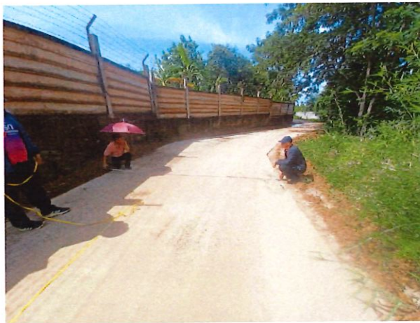
โครงการก่อสร้างถนน คสล. หมู่ที่ ๘ (ซอยแจ้งสว่าง ๓/๒)
