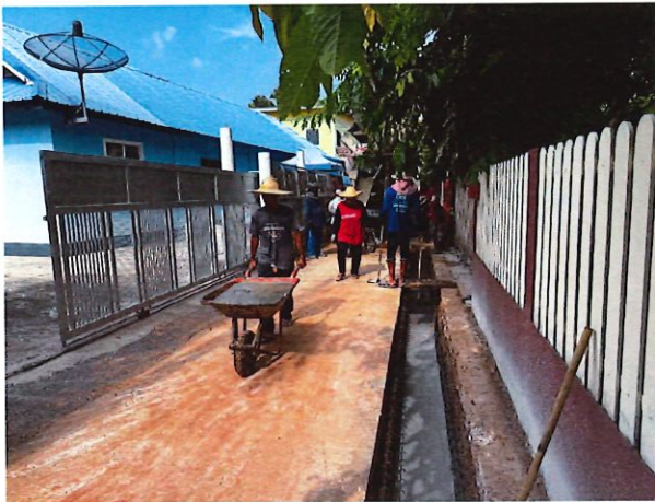
โครงการก่อสร้างรางระบายน้ำ คสล. หมู่ที่ ๑๒ (ซอยโคกแมงเงา ๔)
